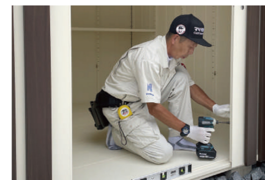
現場で施工している当社の社員
